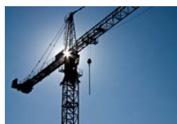
STAVEBNÍ ZDVIHACÍ ZAŘÍZENÍ
